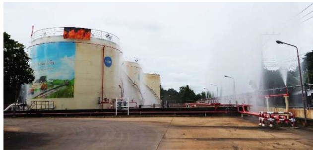
ภาพ 8 การทำงานของระบบหล่อเย็นอัตโนมัติและม่านน้ำกันรังสีความร้อน
